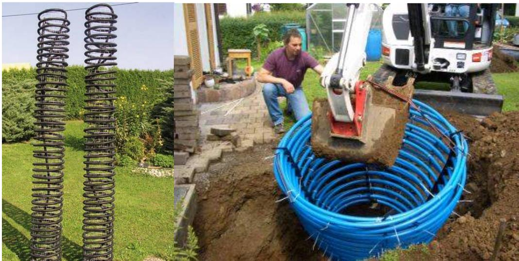
**Abb. 9** Spiralsonden [16] und Erdwärmekörbe [17] als mögliche Wärmequellen.
